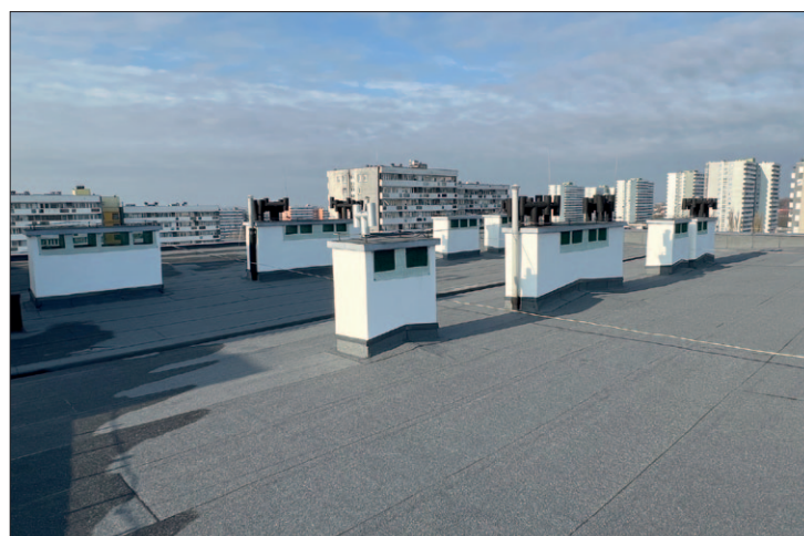
Chrobrego 38 - zakończony remont dachu na segmencie piwnicznym
