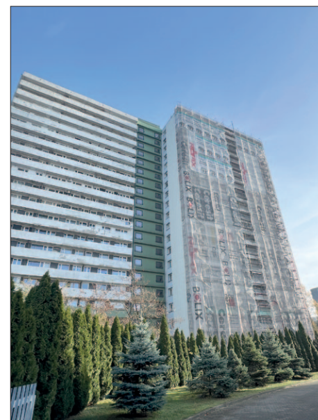
Ułańska 5 - trwający remont elewacji segmentu garażowego po stronie zachodniej
