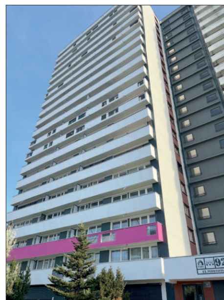
Tysiąclecia 92 - zakończony remont elewacji segmentu piwnicznego po stronie zachodniej
